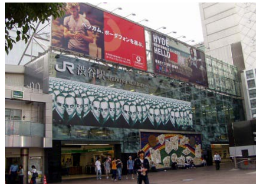
駅舎壁面・屋上利用の広告物 渋谷
