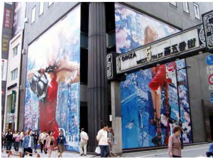
工事仮囲い利用の広告物 銀座
